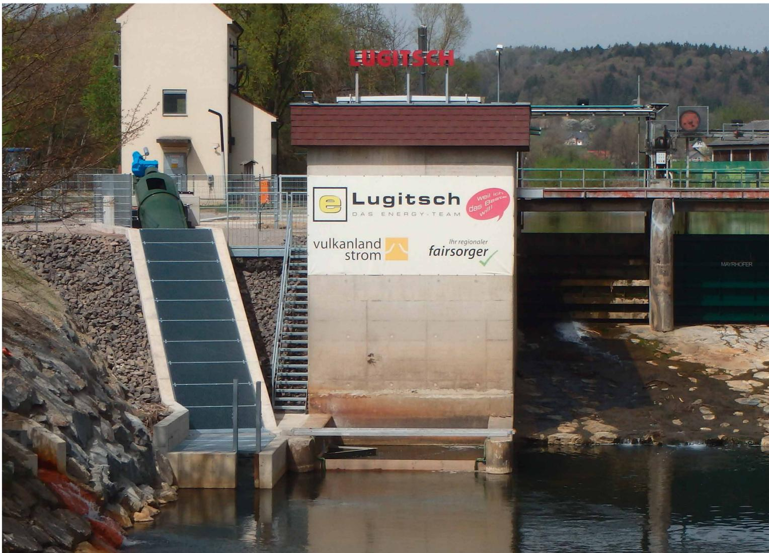
KW Lugitsch Kaplanturbine H=5,3m , Q=6m<sup>3</sup>/s samt Fischaufstiegsschnecke
