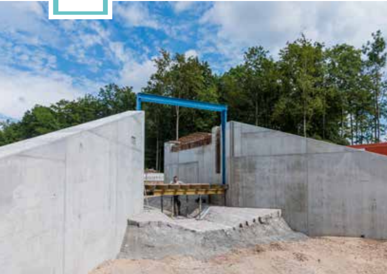
Einbau des Führungsrahmens einer Stauklappe
