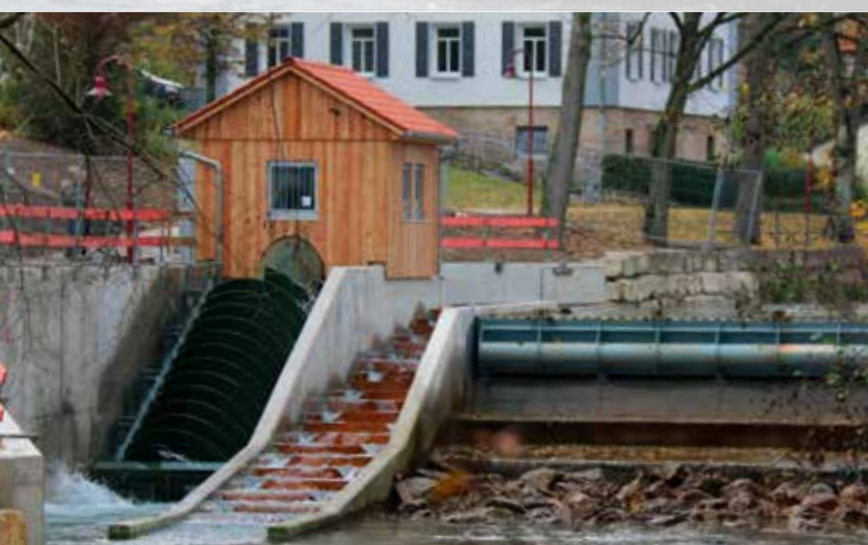
WASSERKRAFTSCHNECKE UND WEHRKLAPPE
