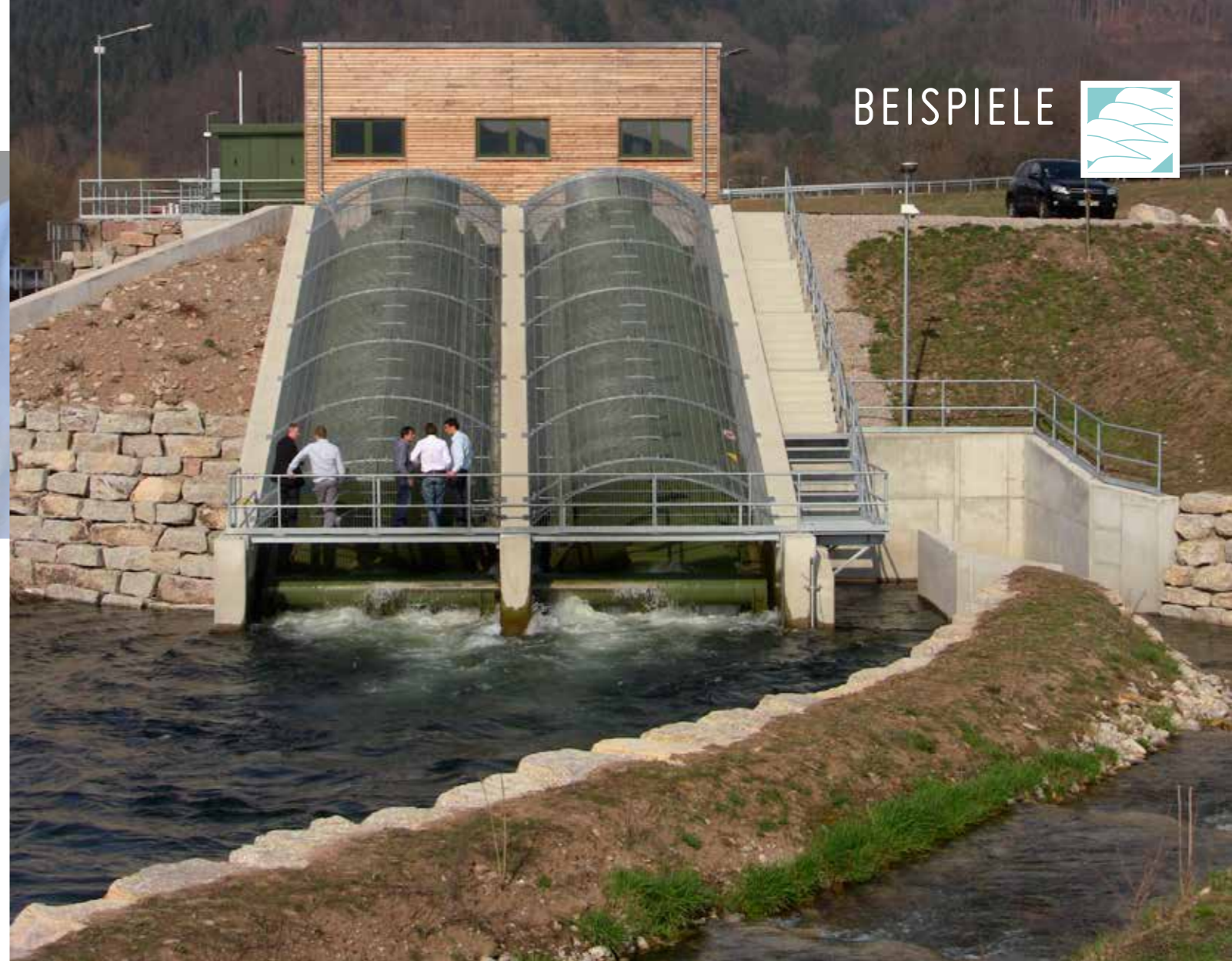
500 kW Anlage, Stahltrog zum Hintergießen (Typ SH), Hausen im Wiesental
