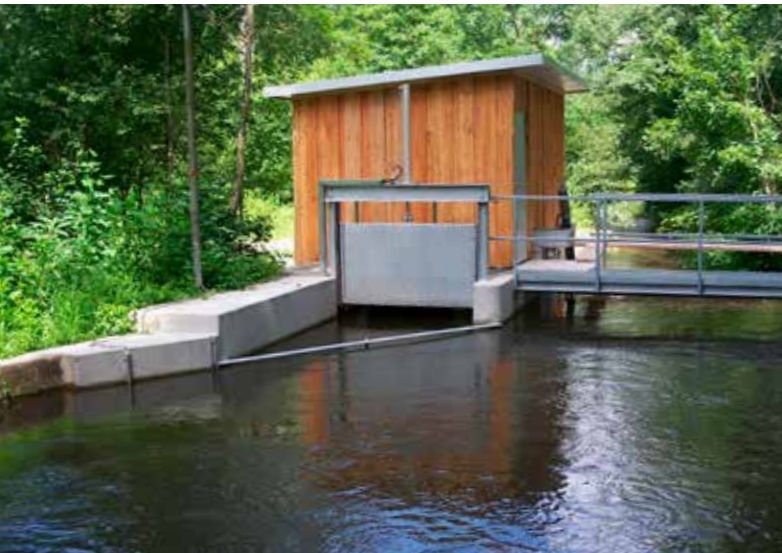
Notschlussschieber vor einer Wasserkraftschnecke
