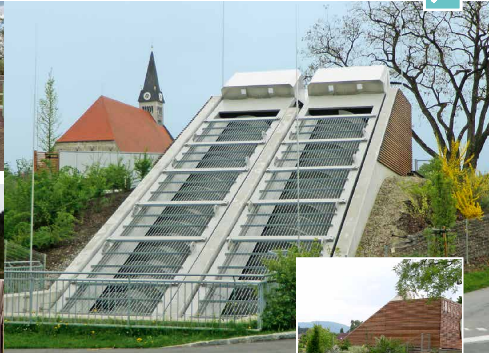
Wasserhebeanlage zum Hochwasserschutz in Oberndorf, Österreich
