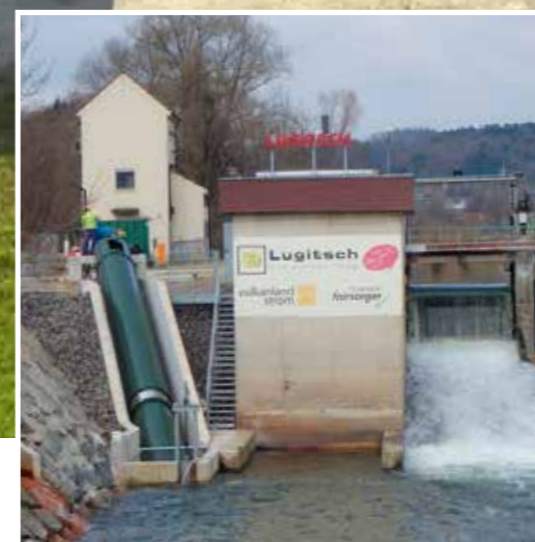
FAS neben einer Turbinenanlage
