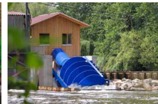
Hybrid Anlage (Typ BS), Baiersdorf
