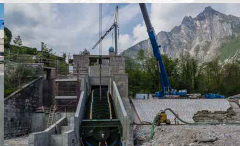
EINBAU EINER ANLAGE IN DEN DOLOMITEN
