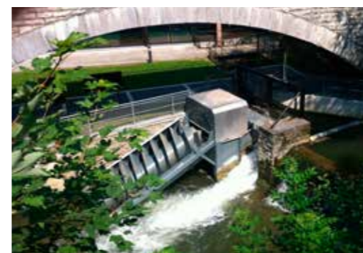
Kompaktanlage (Typ CS), Yvoir, Belgien
