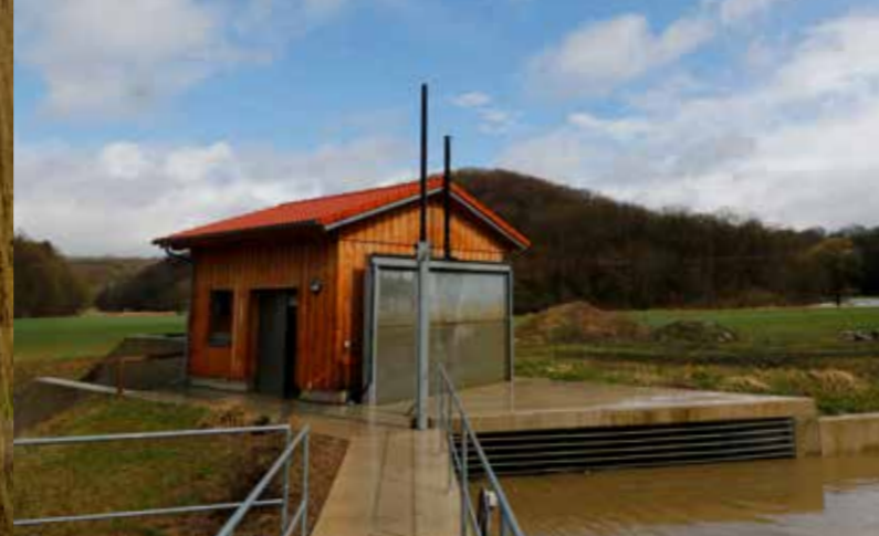
GROBRECHEN UND SCHIEBER IM ZULAUF
