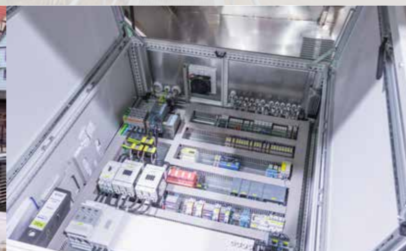
BLICK IN DEN SCHALTSCHRANK
