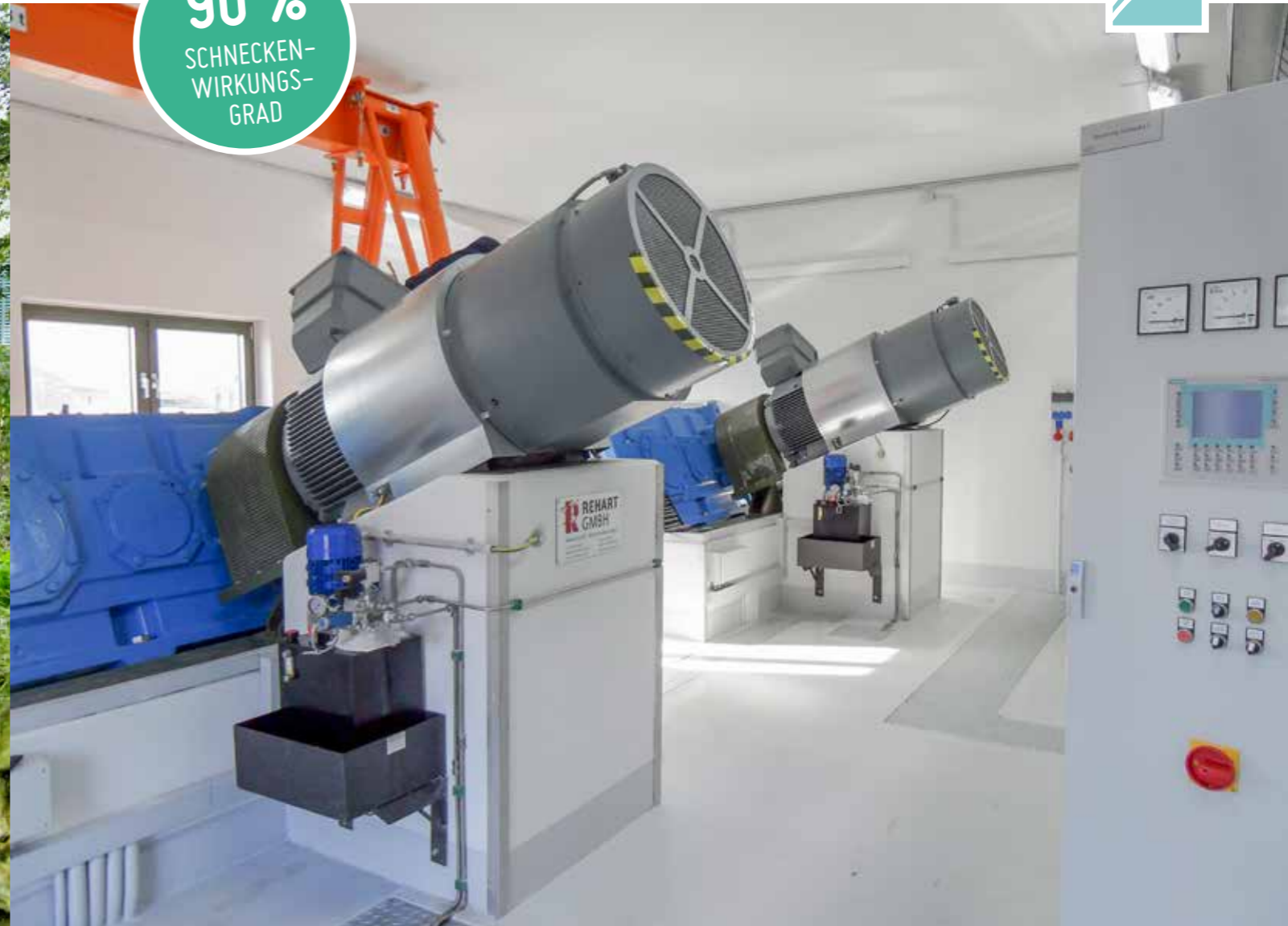
Maschinenhaus einer Großanlage
