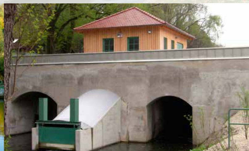
VOLLSTÄNDIG EINGEHAUSTE ANLAGE
