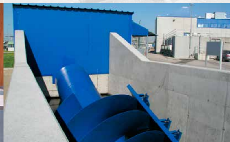
ANLAGE IM AUSLAUF EINES KLÄRWERKES
