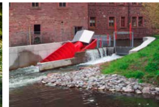
Kompaktanlage (Typ CS), Lohr am Main
