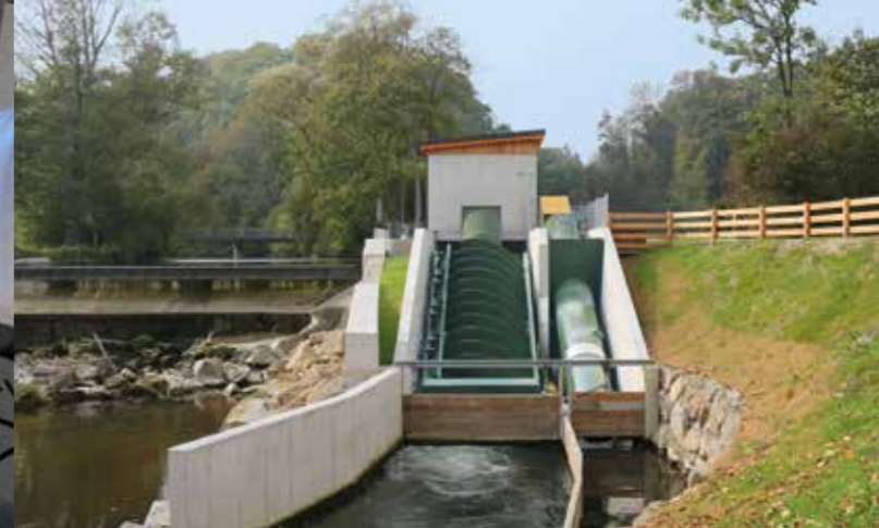
ANLAGE MIT FISCHAUFSTIEGSSCHNECKE FAS
